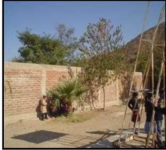
CIERRE PERIMETRAL S. J. OBRERO
