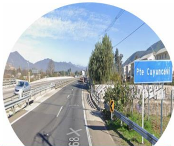
Nuevos Puentes y Reemplazos de puentes (Cuyuncaví; Cuyuncaví Calle de Servicio Derecha e Izquierda; Curacaví Ambas Pistas; Challaco)
