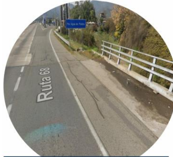
Mejoramiento y rehabilitación de puentes (Agua Piedra Ambas Pistas)
